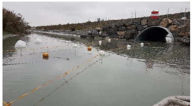
Fischreuse samt Biberschutzzaun am neuen Durchlass am rechten Rheindamm in Hard
