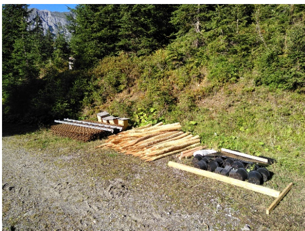
Baustelleneinrichtung für die Umweltbaustelle im Klostertal
