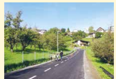
Der Schulweg in Fellengatter ist sicherer geworden.
