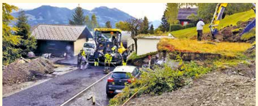
Ende nächsten Jahres sollen alle Arbeiten für die Kanalisierung und Trinkwasser-
