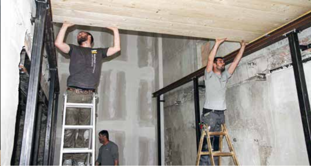
Fotos von den Bauarbeiten: VMW
