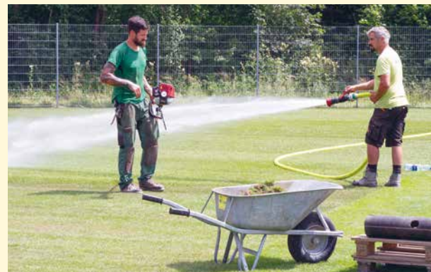
Für die Fußballer wurde ein stabiler Rollrasen verlegt.
