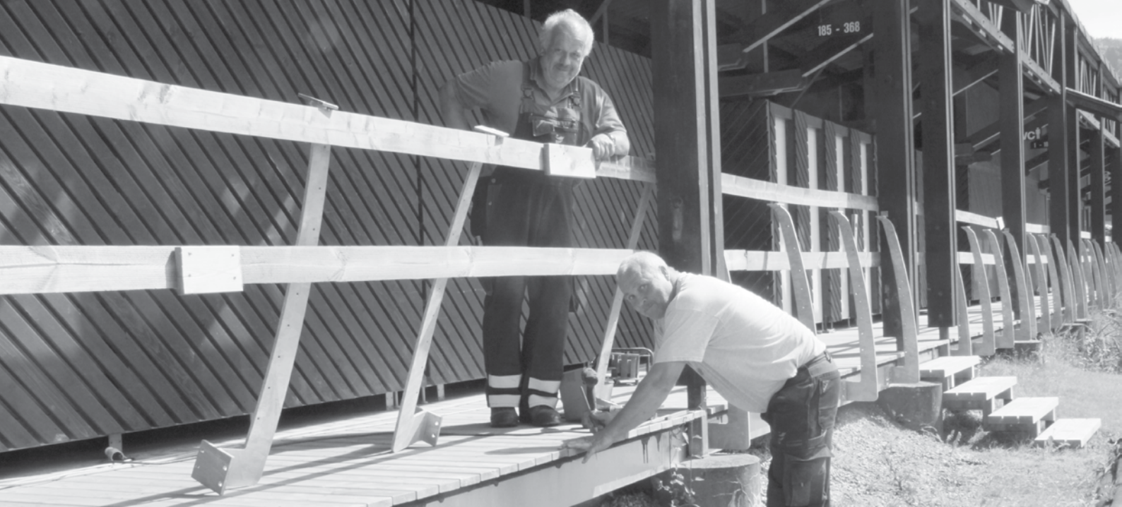
Reinhard Arzbacher und Thomas Riedmann bei der Montage der neuen Eigenbau-Geländerstützen.
