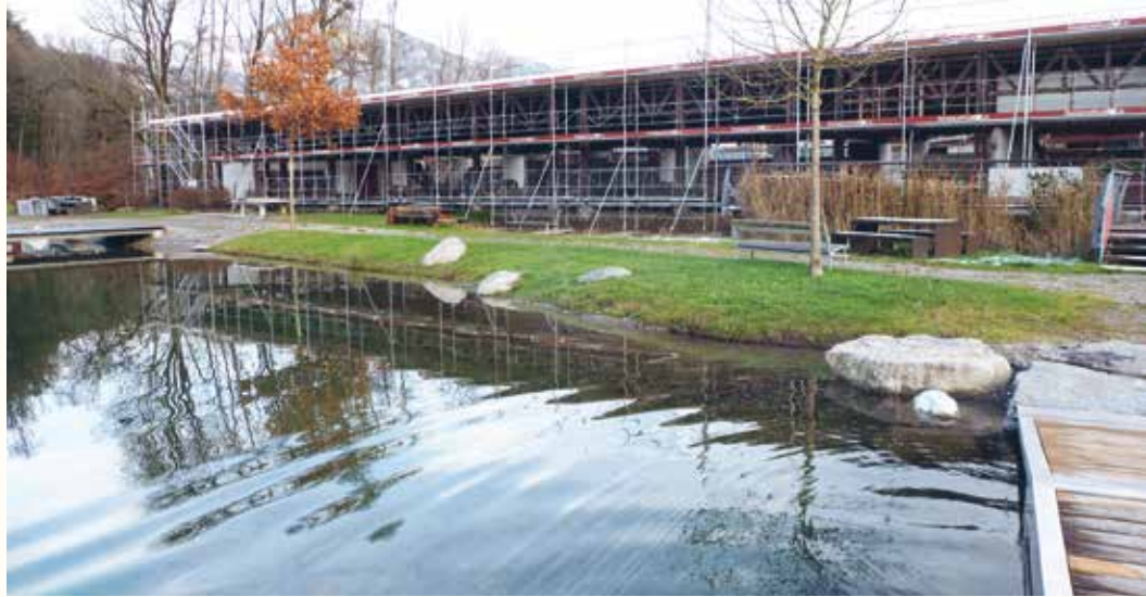
An den Kosten für die Sanierung der Badeanlagen in der Unteren Au beteiligen sich alle Mitgliedsgemeinden der Regio Im Walgau.
