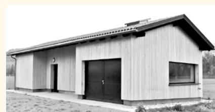
Das Pumpwerk Sonnenheim wurde ebenfalls saniert. Foto: R. Decker
